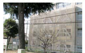
1号館東面外壁耐震補強工事▶
