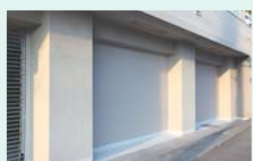
大学・短大1号館外壁
